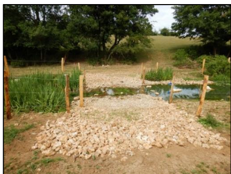
Exemples de franchissements type passage à gué - Chaussée à Curzay- sur-Vonne, 2022 ; et Bouleure à Voulon, 2011) (SMVCS)
