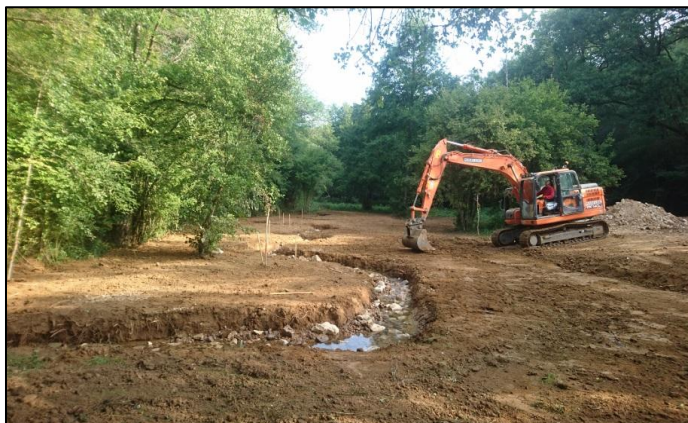
Exemple de suppression de remblais historiques en zone humide avant aménagement d'un cours d'eau en fond de talweg - Torchaise, bassin de la Boivre (SCA)
