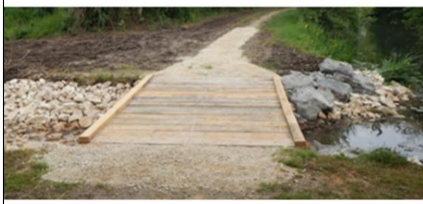
Exemple de reconnexion de zone humide par la pose d'un ouvrage de répartition des eaux - Bassin de la Clouère (CEN)
