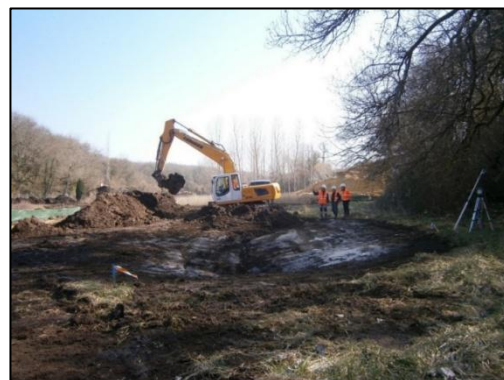
Exemple de chantier de création d'une mare (CEN)
