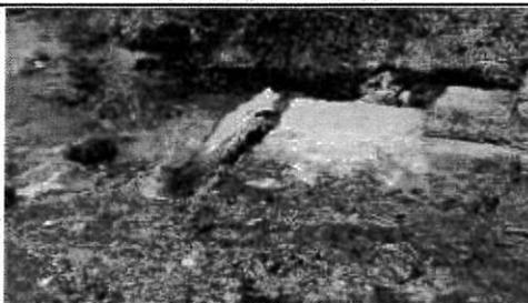
Partie écroulée du parement aval du seuil côté rive droite
