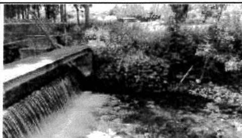
Gabion dégradés en rive gauche en aval du clapet -> infiltrations fortes et berges qui se désagrègent
