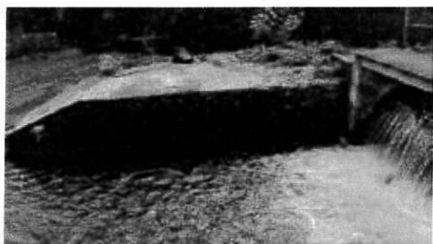
Mur latéral droit en aval du clapet -> infiltrations
