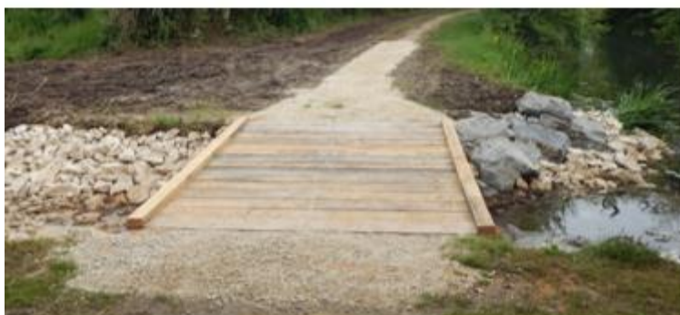
Exemple de reconnexion de zone humide par la pose d'un ouvrage de répartition des eaux (bassin de la Clouère). CREN
