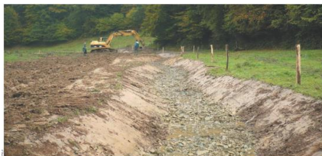
La phase de travaux de la restauration de la Doquette en octobre 2008 : reconstitution du matelas alluvial du cours d'eau par l'apport de matériaux grossiers.
