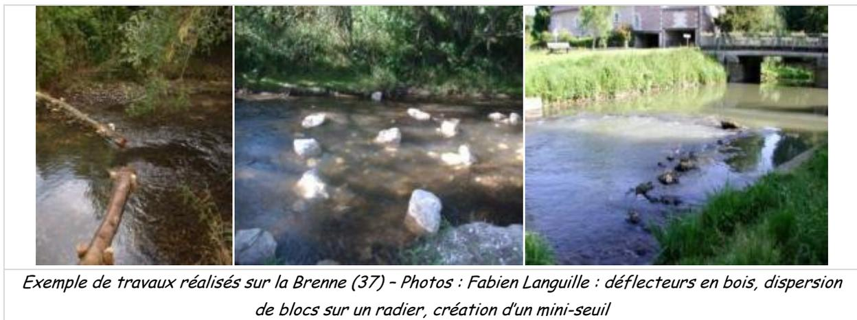
Exemple de travaux réalisés sur la Brenne (37) - Photos : Fabien Languille : déflecteurs en bois, dispersion de blocs sur un radier, création d'un mini-seuil
