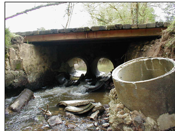
Vue aval du pont du Gué Blanchard
