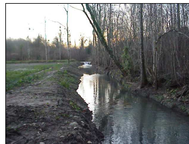
Le lit retravaillé avec les produits de curage régaliés sur les berges en amont de Pontreau.
