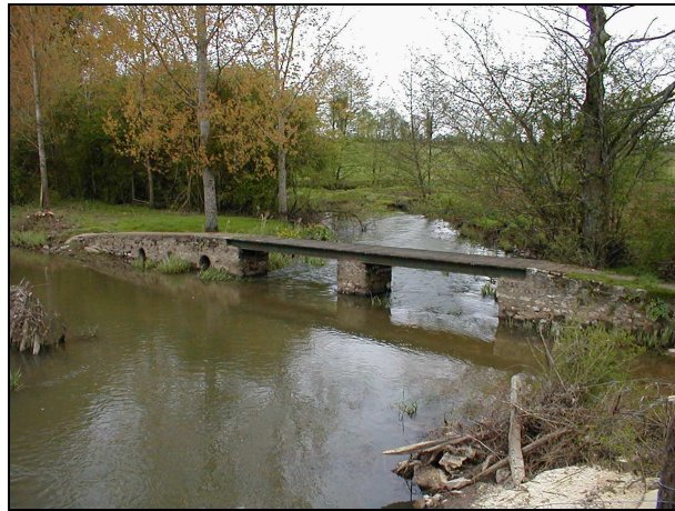
Gué et pont de « Pique Fesse »
