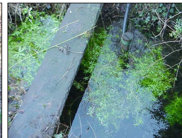
Fossé alimentant l'abreuvoir à poussoir
