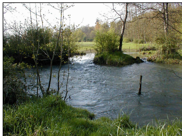
Erosion de berge en aval du seuil du moulin du Pin, les clôtures montrent le recul de la berge.
