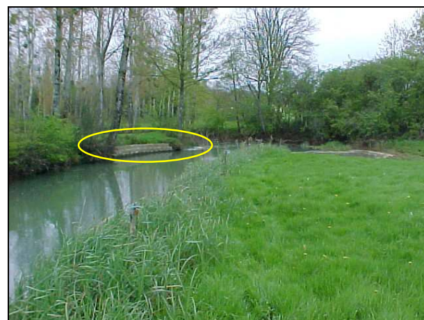
Protection de berge en parpaings à proscrire au niveau d'un chemin creux en rive droite provenant de la Chanfaronnerie
