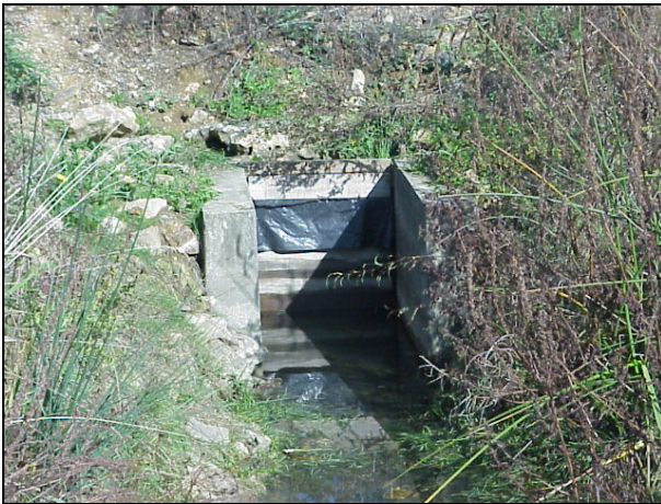
Batardeau, 300 m en aval du Grand Bois Brault
