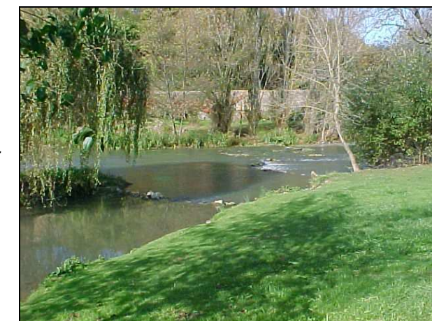
Le radier et le seuil aménagé en aval du pont d'Anché.
