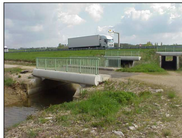
Les ponts au niveau de la N.10
