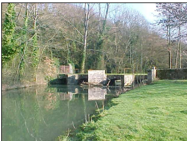
Amont du pont de l'ancienne abbaye : les écoulements et les niveaux sont influencés par la vanne du camping en aval.
