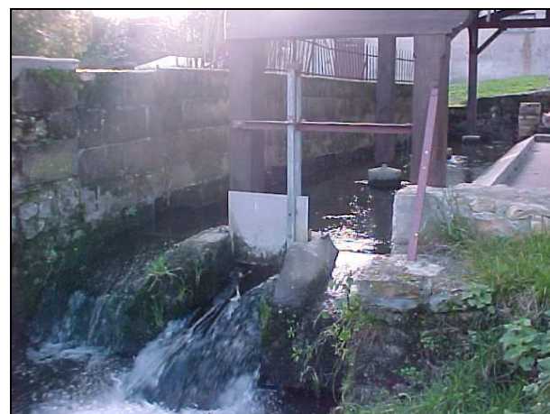
Vanne du lavoir à la confluence avec le Clain.
