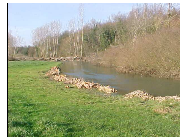
Empierrement en rive droite en aval du clapet de Paplais
