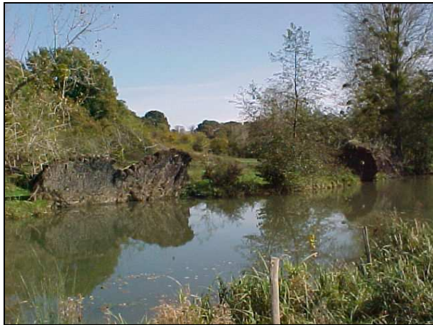
Peupliers déracinés en rive droite en aval du Moulin Ruiné.
