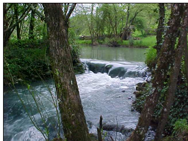
Déversoir amont du moulin de la Grande Métairie
