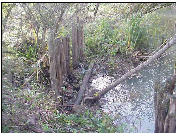
Déversoir radier obstrué par des pieux.
