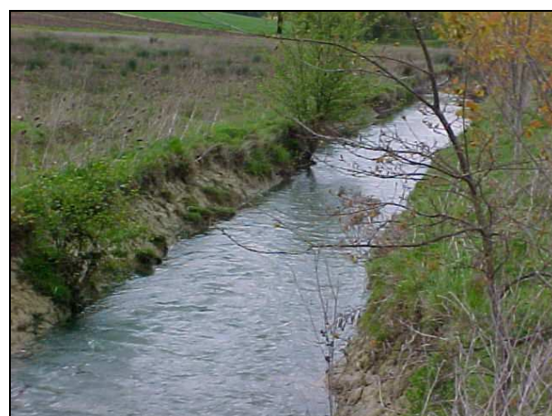
Effondrement de berge en absence ripisylve en aval de Chez Grelet
