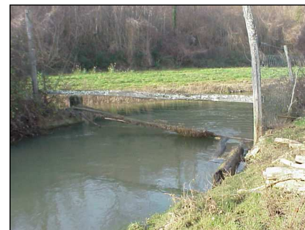
Barrière en travers du lit, confluence Bouleure/Bonvent
