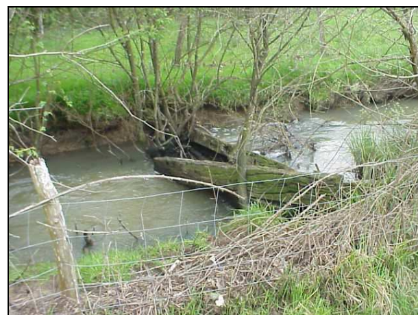
Embâcle formé par des poutres servant pour le pont de la photo précédente
