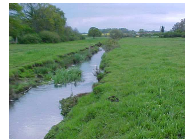
Effondrement de berge en amont de la confluence avec le ruisseau de l'Arquetan
