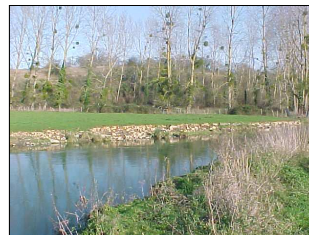
Empierrement de la rive gauche
