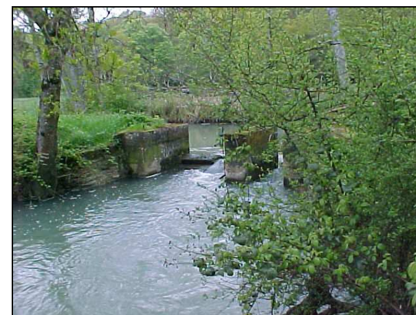
Déversoir en amont du château de Payroux
