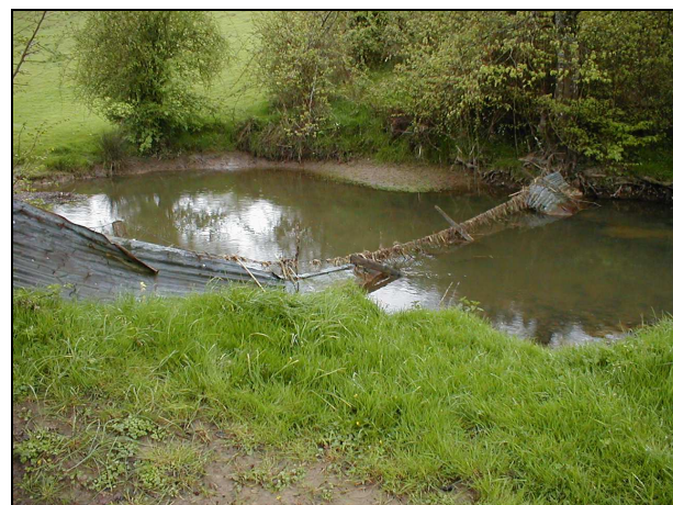
Clôture et tôle ondulée placée en travers de la rivière pour retenir l'eau.
