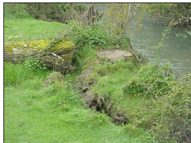
Souche de Peuplier remise en place, au droit de la Belle Indienne
