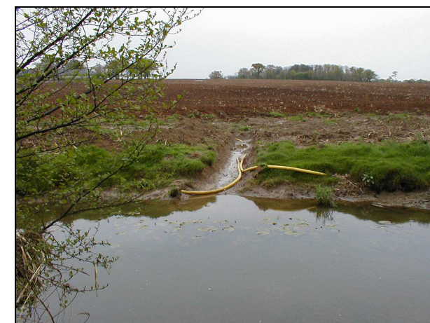
Mise en place de drains à l'Eclopchain.
