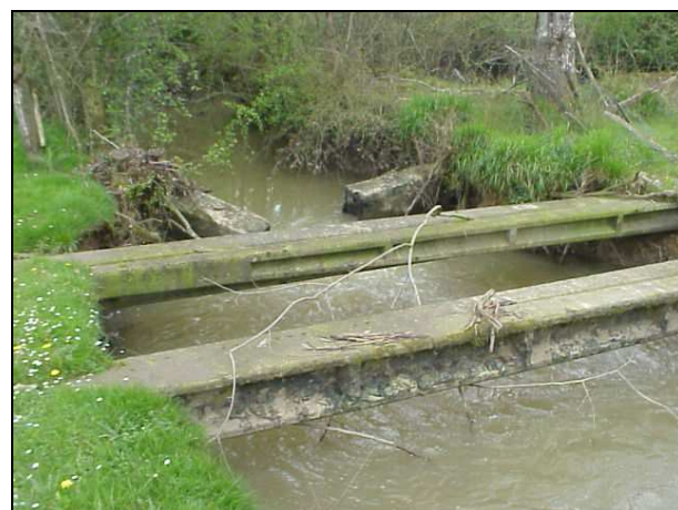
Poteaux EDF + anciennes culées de batardeaux en arrière plan, amont étang de Combours
