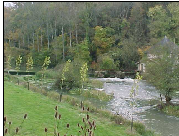
Barrage en amont de Commenjard.
