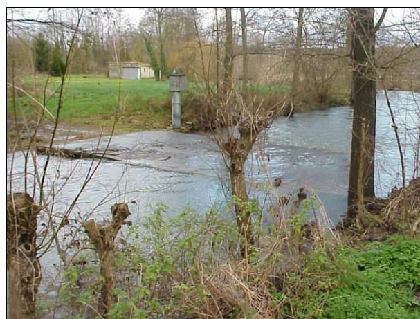
Gué : à garder ou à démolir ?
